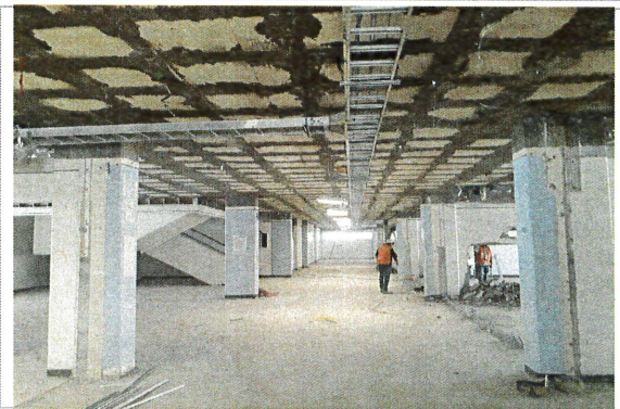
F5: Interior de aula 1
